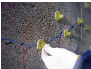
座金設置状況
