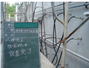
擁壁のASR補修事例
