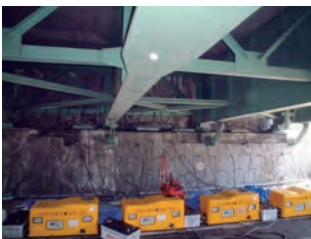
橋台のASR補修事例
