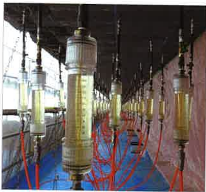
リハビリカプセル工法によるRC床版の塩害補修状況
