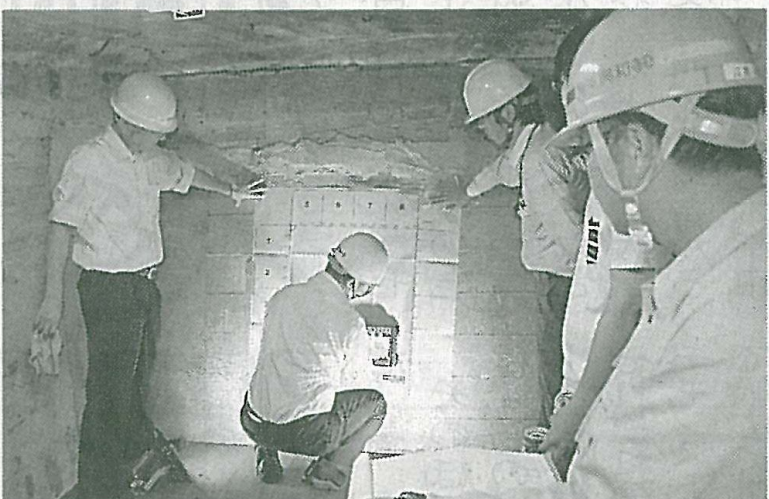
壁内の鉄筋を調べる参加者ら
