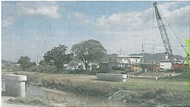
湊川橋の上部工は25年度に着手
